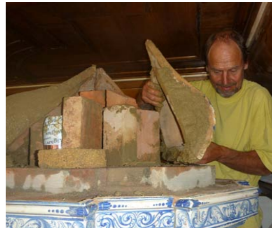
Die Kacheln der Kuppel werden nur mit Lehm-mörtel versetzt. Dazu soll auf keinen Fall Gips verwendet werden.
